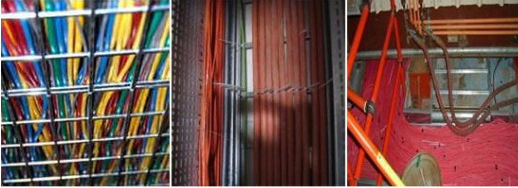
Kabloların yoğun bir şekilde guruplanarak bina içinde döşenmesi
