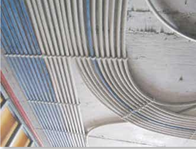
Kablolar montaj esnasında boruların içinden itilerek monte edilir.
