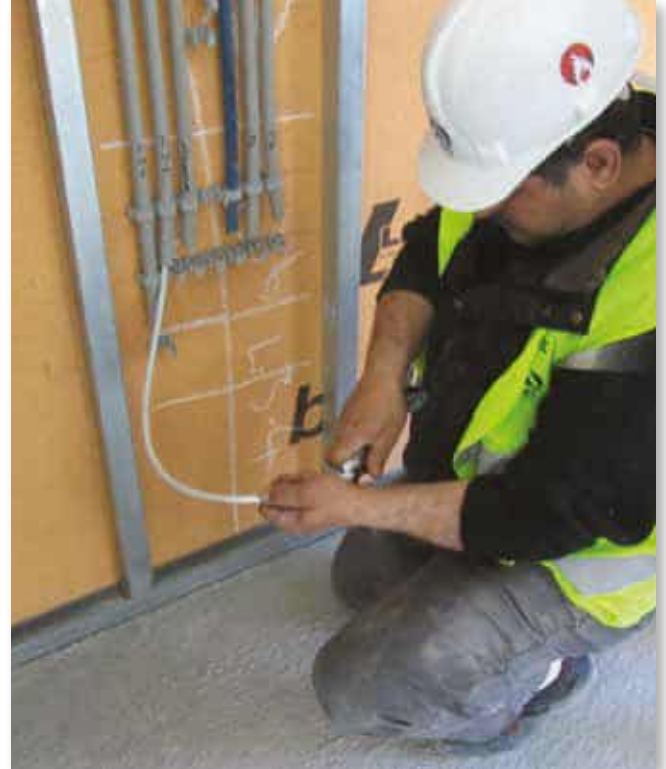
Kablo montajında kılıfın kolay sıyırılması, zaman kazandırır.
