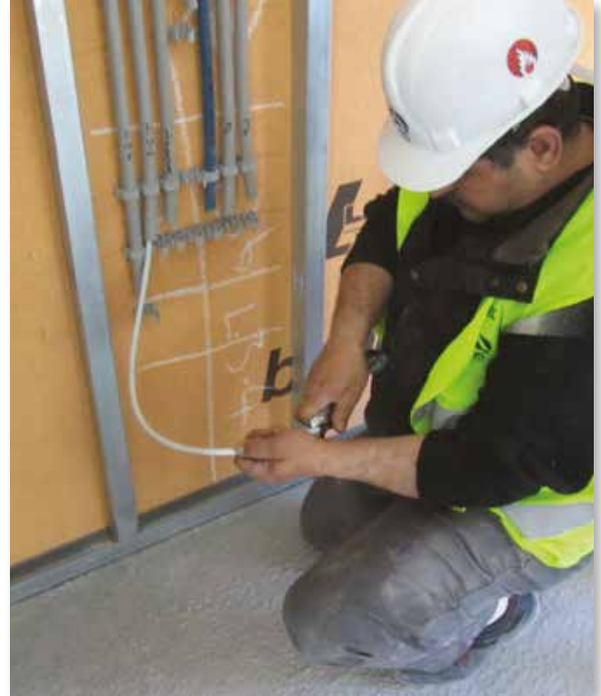
Kablo montajında kılıfın kolay sıyırılması, zaman kazandırır.
